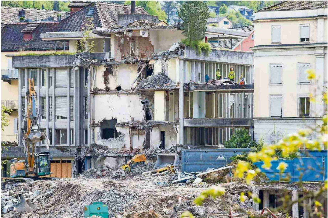
Blick über das Trümmerfeld des früheren Thermalbades zum «Staadhof», wo der Abbruch weitergeht.
