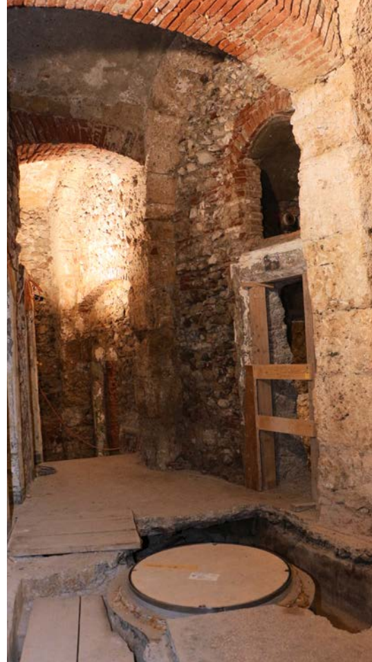
Eine der acht Quellen des Verenaufgevierts. Über Sammelschächte wird das Wasser dem «Fortyseven»-Thermalwasserspeicher zugeführt.
